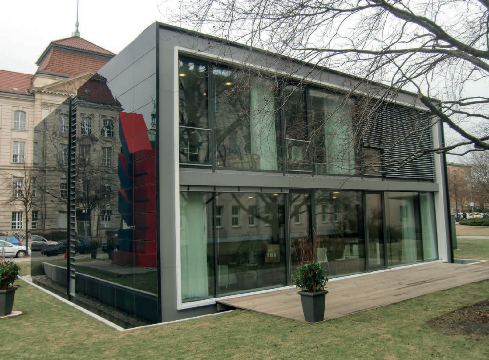
Het eerste PlusEnergiehuis in de EU aan de Fasenenstrasse in Berlijn, ontworpen door dr.-ing. Werner Sobek.
