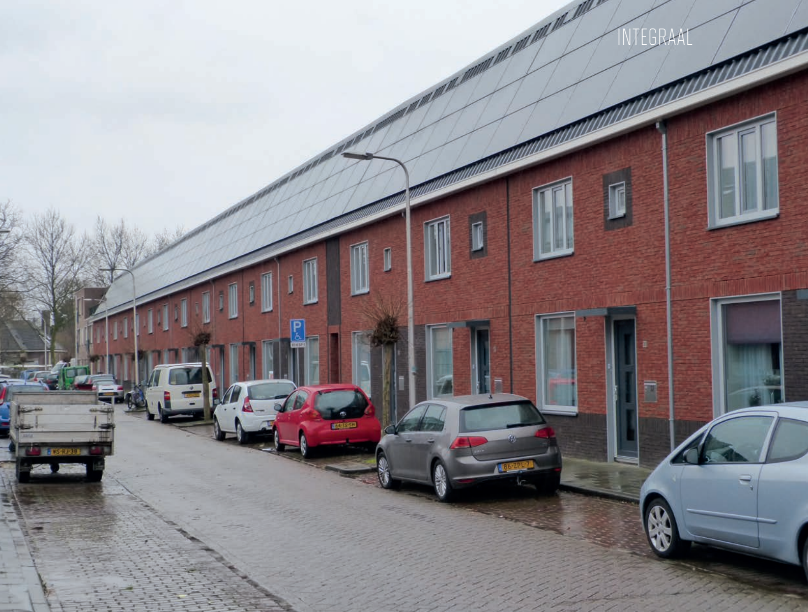
Door Ballast-Nedam gerenoveerde NOM-woningen van corporatie Tiwos in Tilburg.
